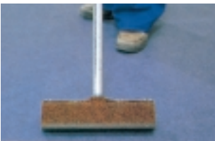
Притирка полос специальной металлической гладилкой, обтянутой тканью...
