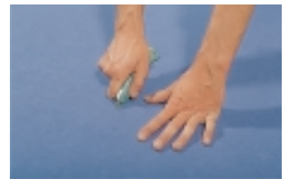
Если воздушный пузырь не удастся "выдавить" сбоку, делают так: линолеум протыкают острием ножа (выбирают по возможности темный участок рисунка), выдавливают воздух и снова тщательно притирают.
