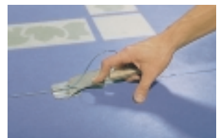
Выравнивание шва производится в два этапа: сначала ножом с "салазками", а затем просто острым ножом.
