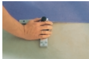
Обрезку первой кромки лучше всего производить кромочным ножом или специальным резаком для линолеума.
