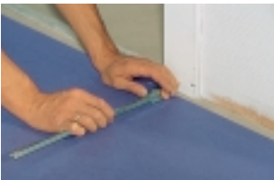
Перенос профиля двери на линолеум с помощью малки.
