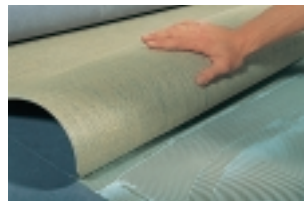
Прирезанные полосы отгибают либо поперек до половины длины помещения, либо вдоль (например, в коридорах).
