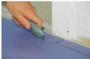
Покрывало вырезается по намеченному контуру.
