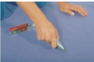
Срезание верхней кромки с помощью крючкообразного ножа.
