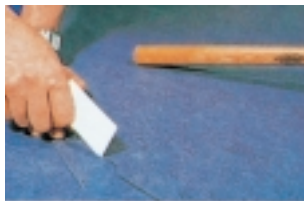
Шов не должен быть слишком плотным, между кромками соседних полос должен оставаться зазор около 0,5 мм.
