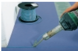
Сварка аппаратом для ручной сварки
