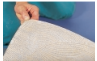
Клей наносится так, чтобы он полностью смочил всю обратную сторону покрытия.
